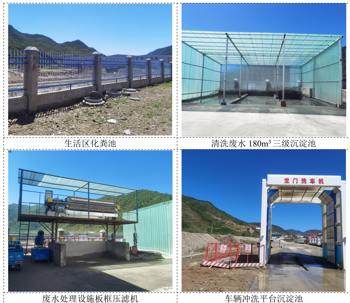
图 5 废水治理设施建设情况
