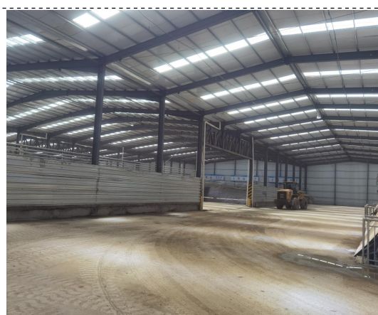
全封闭原料堆棚
