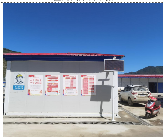
拌和站区扬尘在线监控系统
